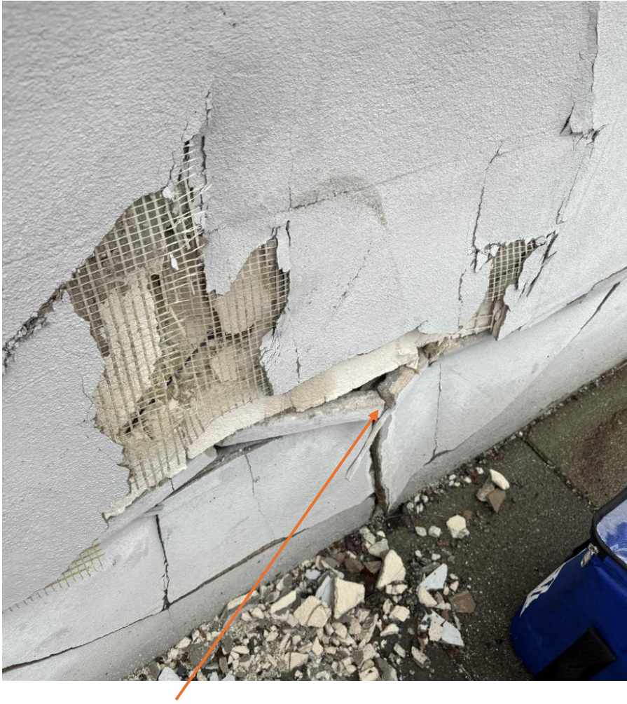
Figur 16. BRFasad04, dilatationsfog fasad Brasilia. Inga halter över laboratorets rapporteringsgräns.
