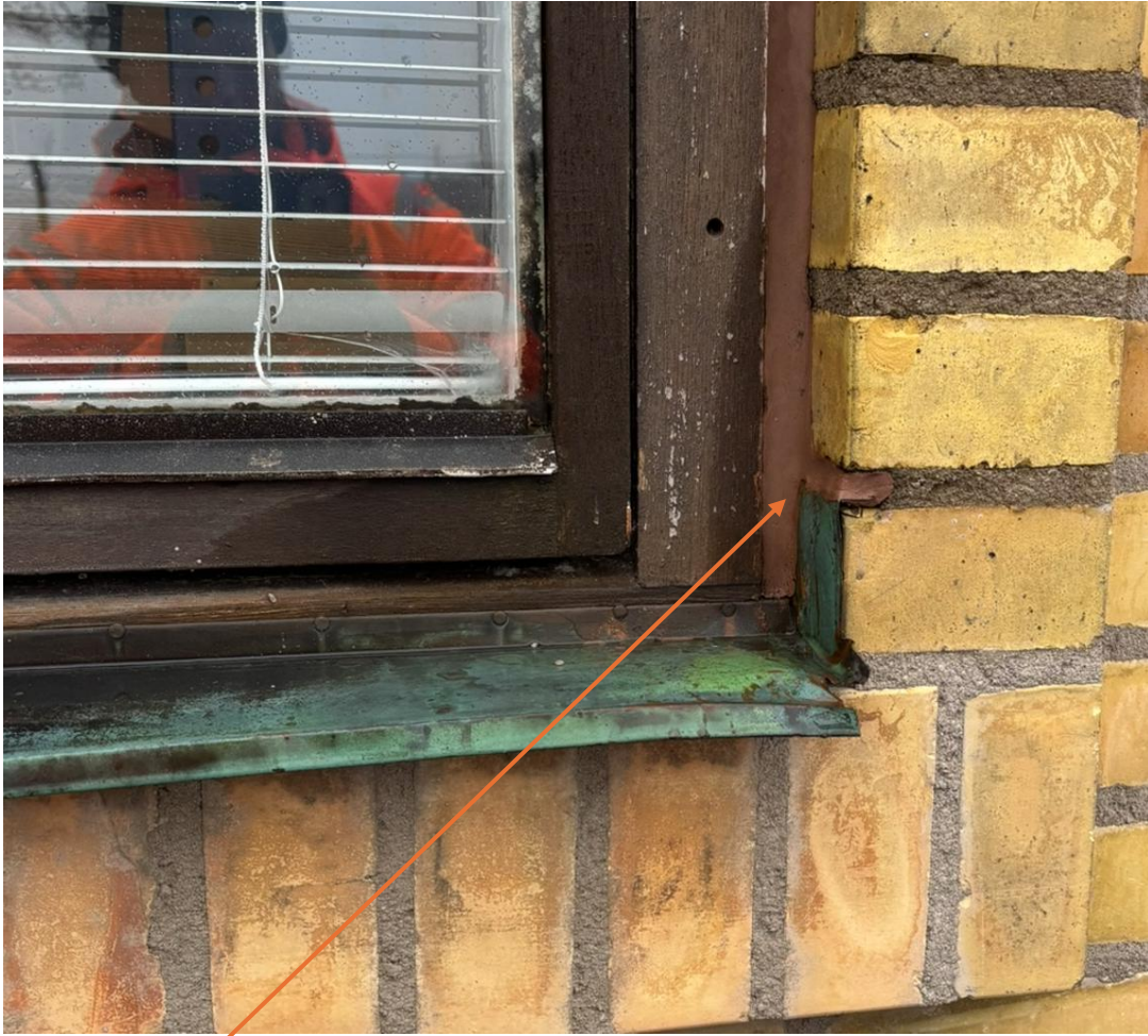
Figur 8. BEFasad01, fönsterfog fasad Begonia. Inga halter över laboratoriets rapporteringsgräns.
