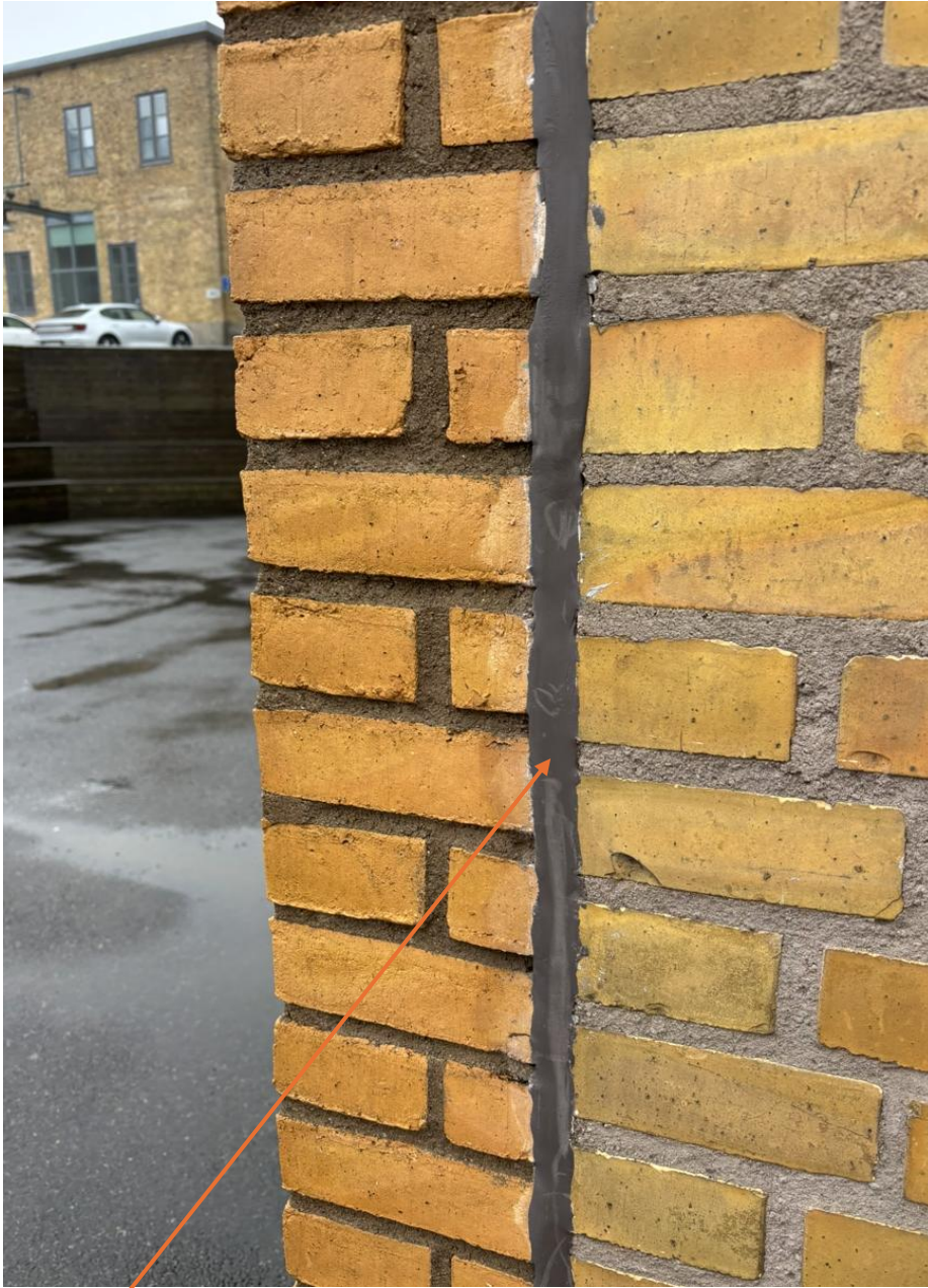
Figur 10. BEFasad03, dilationsfog fasad Begonia. Inga halter över laboratorets rapporteringsgräns.
