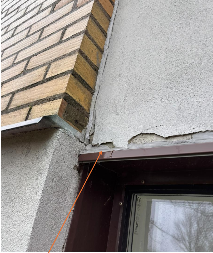
Figur 14. BRFasad02, fönsterfog fasad Brasilia. Inga halter över laboratoriets rapporteringsgräns.
