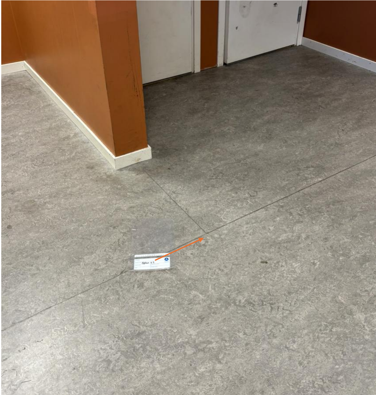
Figur 2. BEplan1.1, mattfog från Plan 1 Begonia. Inga halter över laboratoriets rapporteringsgräns.
