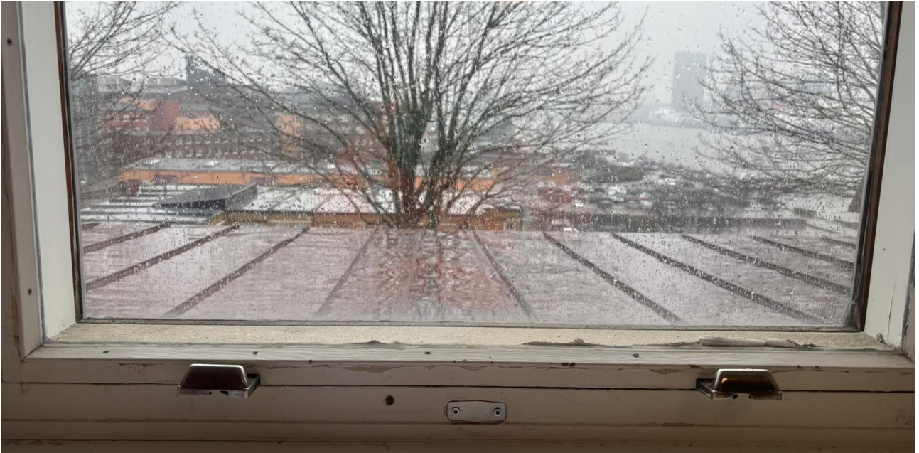
Figur 2. Fönster i äldre utförande som var vanligt förekommande i både Begonia och Brasilia. Foto taget mot öster.
