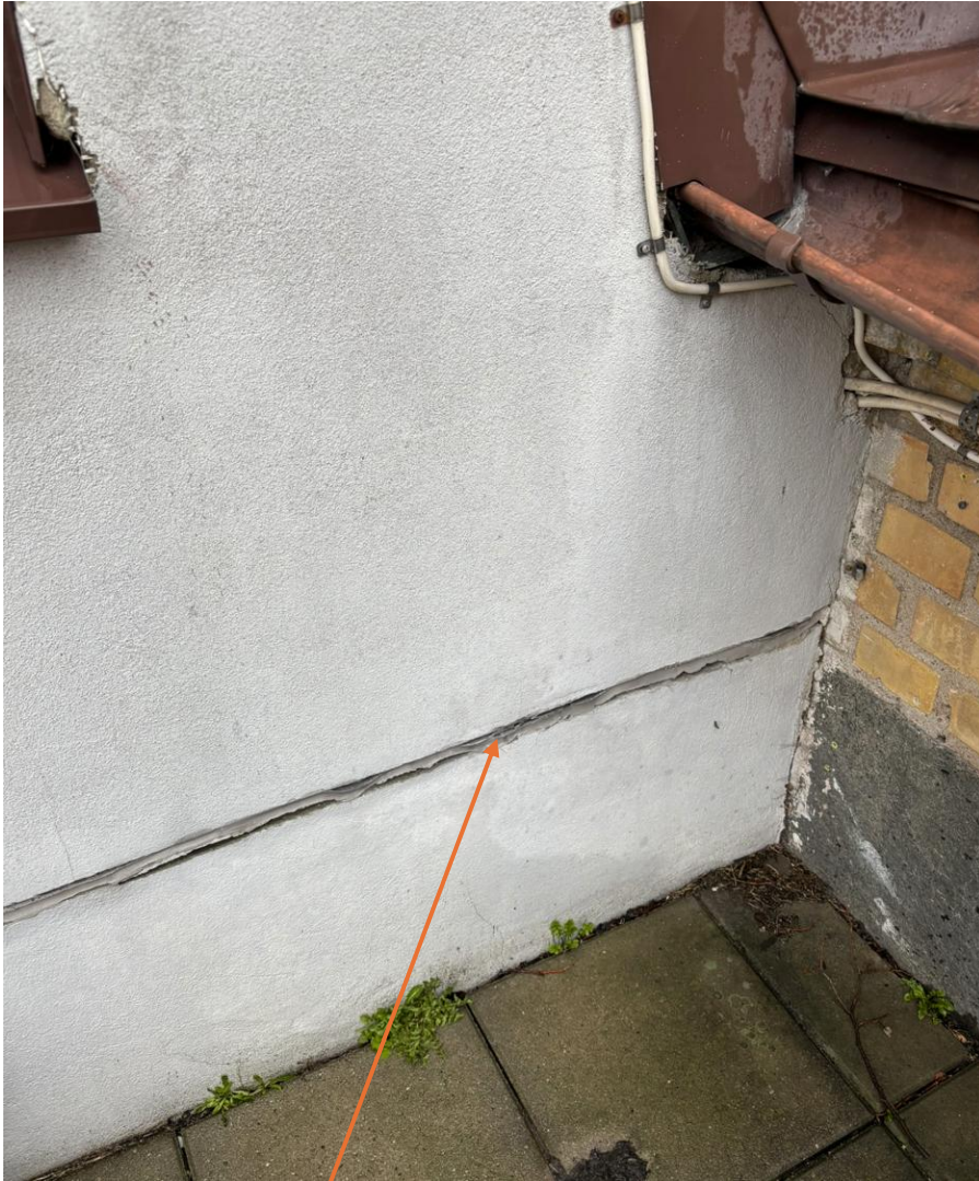
Figur 13. BRFasad01, dilatationsfog fasad Brasilia. Inga halter över laboratorets rapporteringsgräns.
